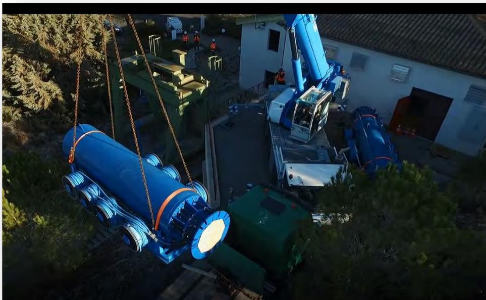
Le renouvellement des pompes s'effectue en moyenne tous les 12 ans. En 2017 ce sont les pompes du puits n° 1 qui ont été changées. L'ensemble de l'opération qui comprend la réalisation des nouvelles pompes est de 52 semaines. Ces dernières étant fabriquées spécialement pour l'usine, elles viennent d'Allemagne.
