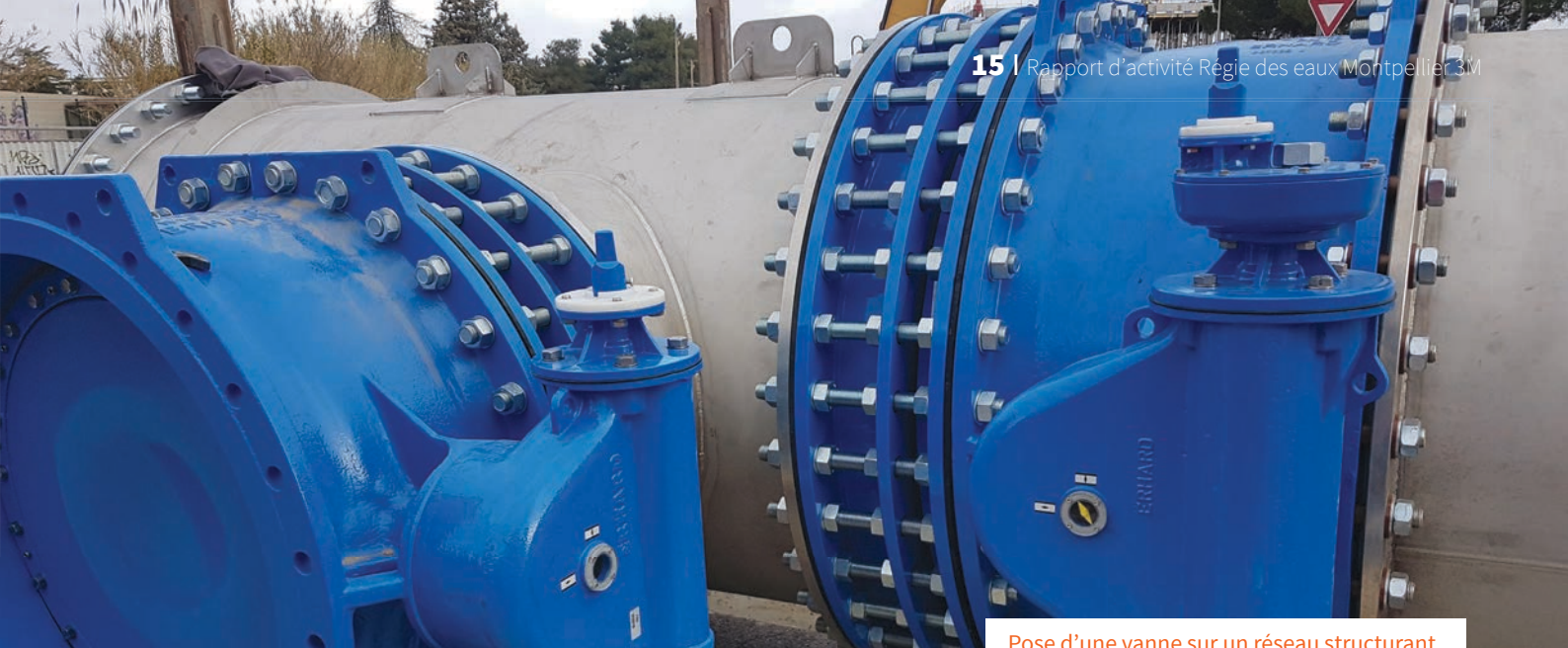
Pose d'une vanne sur un réseau structurant
