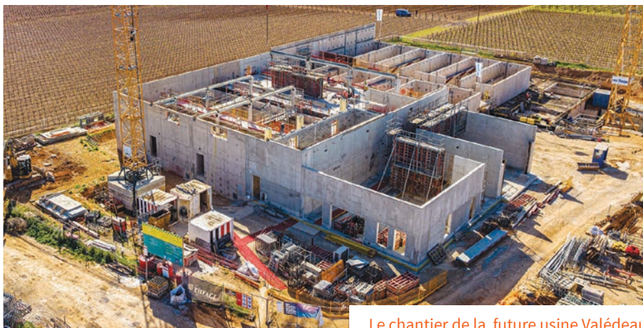
Le chantier de la future usine Valédeau
