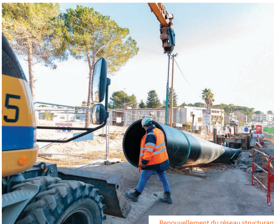
Renouvellement du réseau structurant
