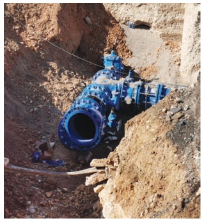
Chantier rue Fontcouverte, Montpellier
