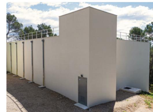
Travaux achevés sur le réservoir de Prades-le-Lez en décembre 2024, avec la construction d'un réservoir d'eau potable supplémentaire de 2 000 m<sup>3</sup> à côté de l'actuel château d'eau, ces travaux permettent de sécuriser l'alimentation en eau potable de la commune dont la population augmente.
