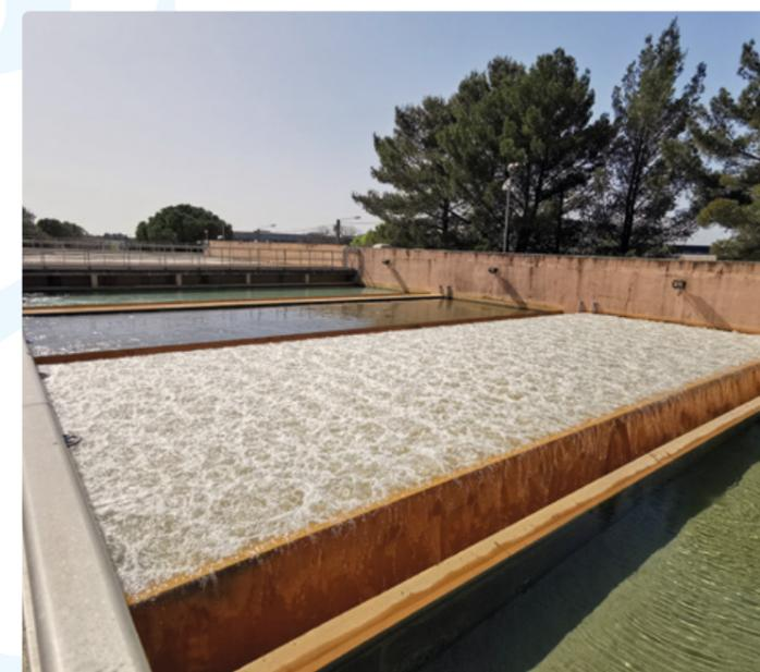
L'eau prélevée dans les ressources souterraines de la source du Lez est de bonne qualité, l'eau passe par des filtres à sable pour être traitée.
