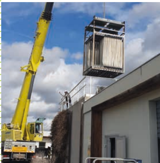
Renouvellement de membranes STEP de Baillargues Saint-Brès
