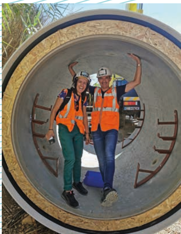
Le renouvellement d'un Feeder d'eau potable (canalisation porteuse de gros diamètre) est toujours un chantier d'envergure.
