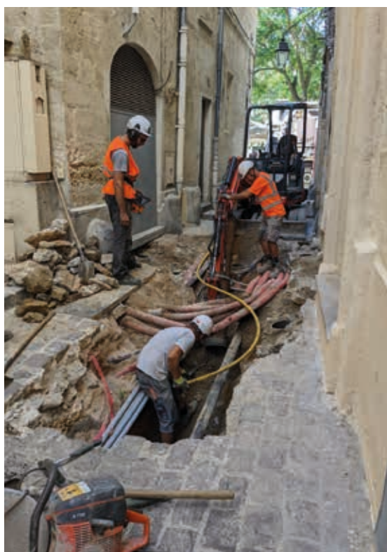
Travaux d'assainissement Rue de la Loge
