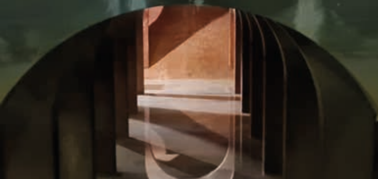
Nettoyage d'un réservoir
