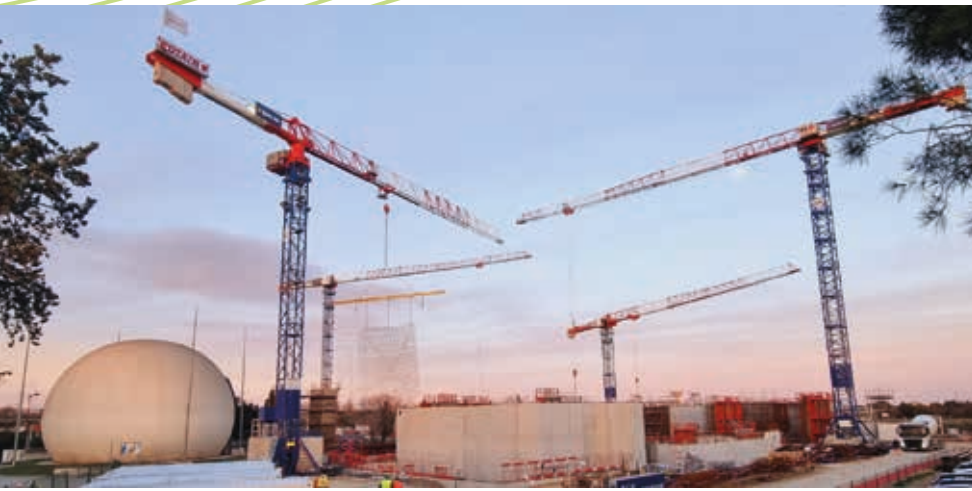
Sortie de terre du 1 er bâtiment
