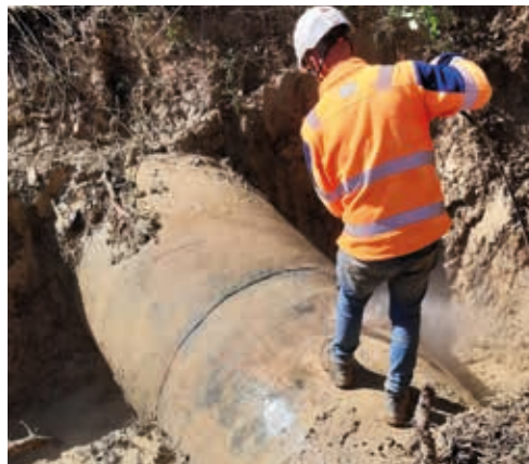
Réparation du DN 1400, Saint-Clément-de-Rivière
