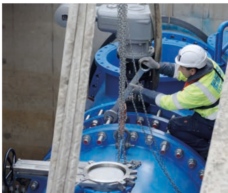
Travaux sur l'émissaire
