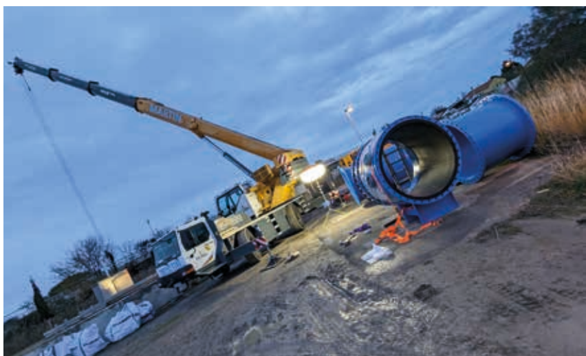
Travaux sur l'émissaire
