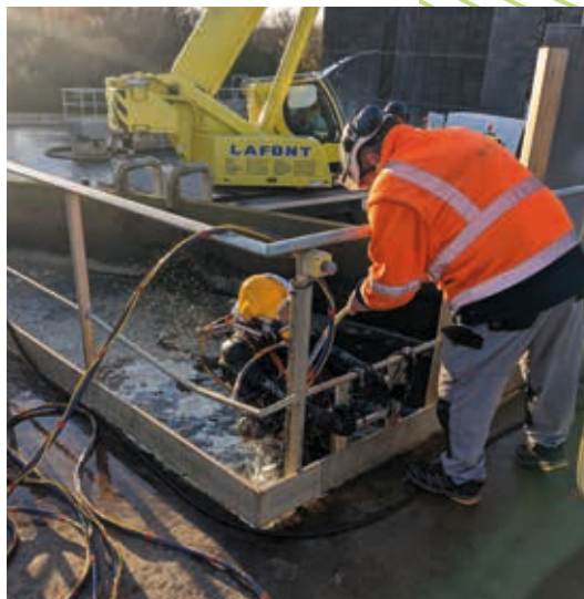
Enlèvement des filasses dans le bassin d'aération à Villeneuve-lès-Maguelone
