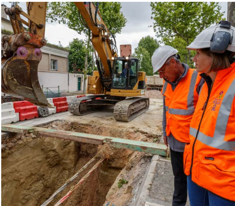
Chantier de réparation de fuite sur une conduite en béton de DN 900 à Montpellier.
