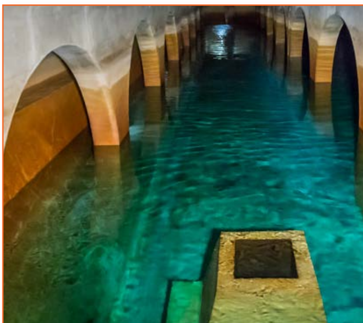
Réservoir de Montmaur à Montpellier.
